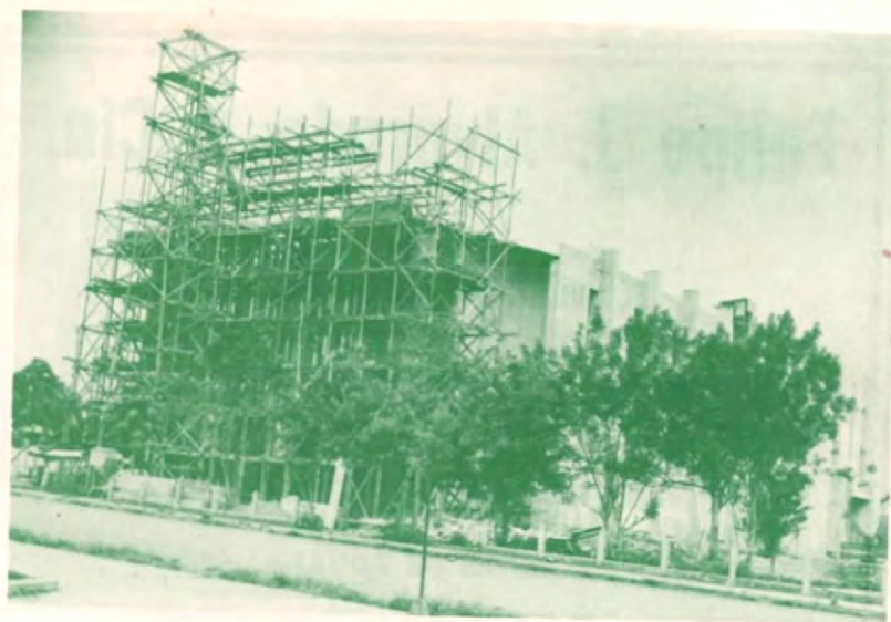
La Catedral de San Isidro de el General en construcción. - 1960.
